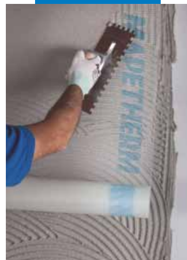
Esecuzione della rasatura armata con interposizione della rete Mapetherm Net
