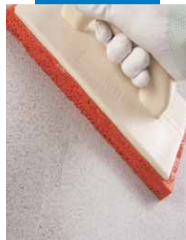
Rifinitura della rasatura con frattazzo di spugna
