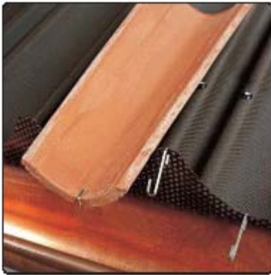
Fase 3: posizionare i ganci fermacoppo per griglia negli appositi fori e agganciare i coppi.
