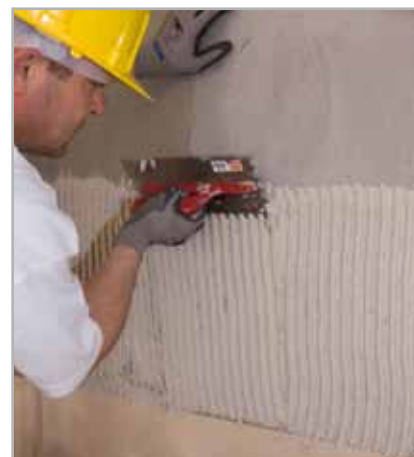
Fig. 18 - Applicazione di ULTRALITE S2 su intonaco strutturale PLANITOP HDM MAXI armato con MAPEFGRID G 120
