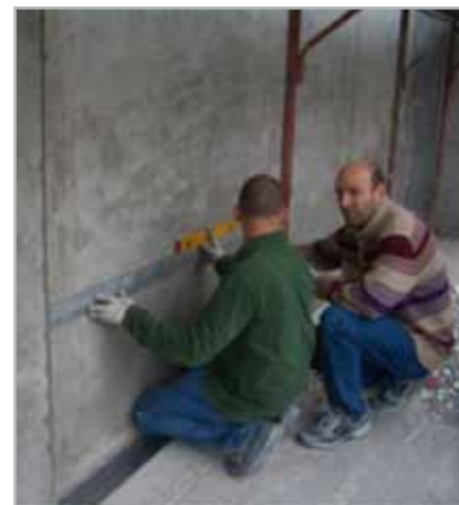
Fig. 5 - Verifica planarità del supporto
