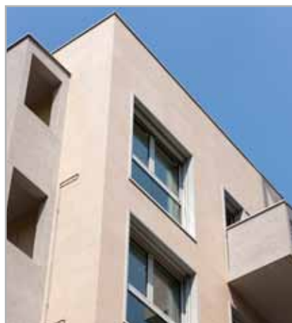
Fig. 3 - Edificio residenziale rivestito con Mapetherm Tile System
