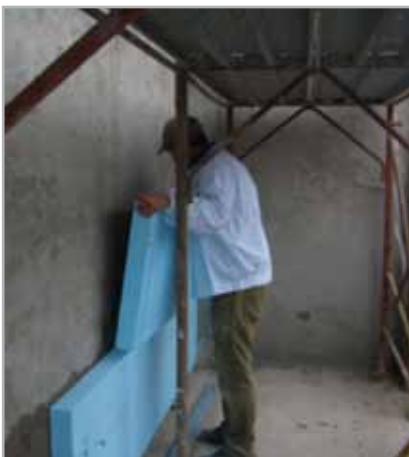
Fig. 9- Posa in opera del pannello
