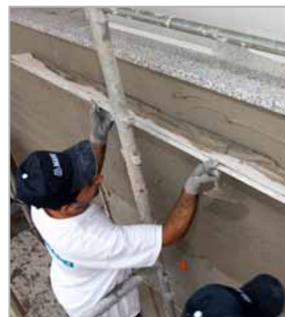
Fig. 16 - Applicazione seconda mano di PLANITOP HDM MAXI
