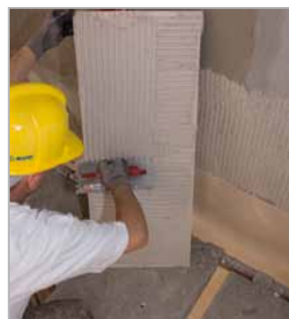
Fig. 19 - Applicazione di ULTRALITE S2 sul rovescio delle lastre di gres porcellanato
