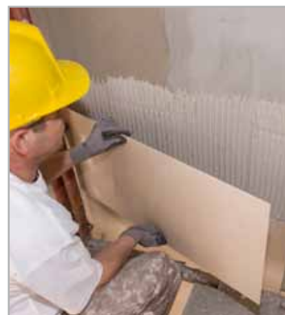
Fig. 20 - Posa in opera delle lastre di gres porcellanato
