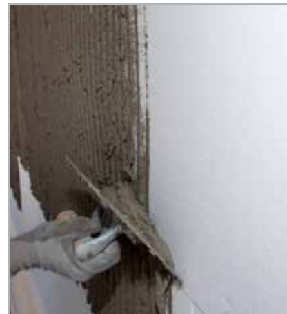
Fig. 10 - Applicazione di PLANITOP HDM MAXI sulla superficie dei pannelli in EPS
