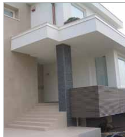
Fig. 1 - Edificio residenziale rivestito con Mapetherm Tile System
