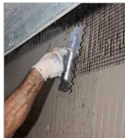
Fig. 11 - Armatura della prima mano di PLANITOP HDM MAXI con MAPEGRID G 120
