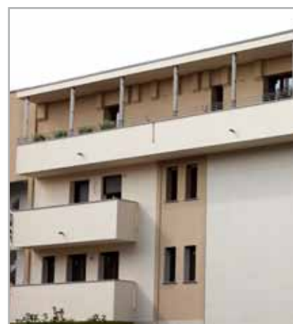
Fig. 2 - Edificio residenziale rivestito con Mapetherm Tile System
