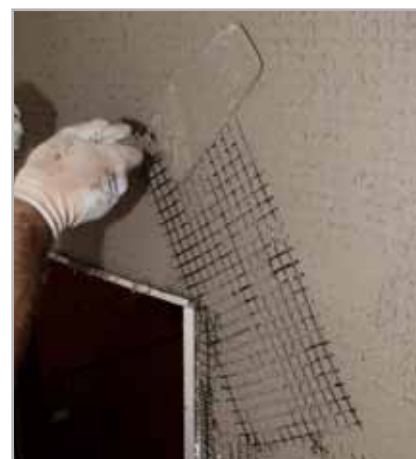
Fig. 12 - Posizionamento di porzioni di MAPEGRID G 120 in corrispondenza degli spigoli delle aperture
