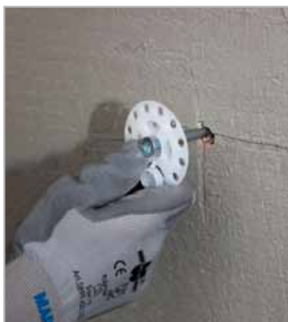
Fig. 14 - Applicazione di MAPETHERM TILE FIX 15
