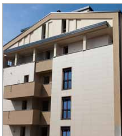
Fig. 4 - Edificio residenziale rivestito con Mapetherm Tile System
