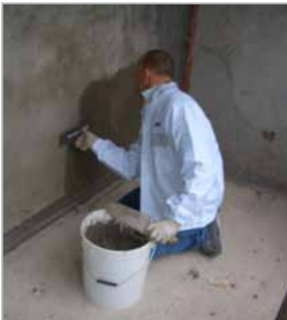
Fig. 8 - Stesura dell'adesivo sul supporto
