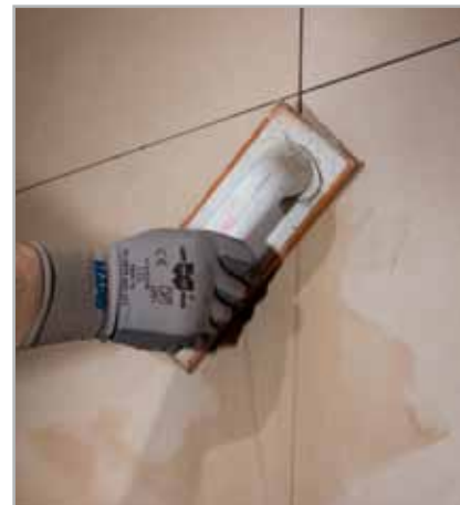
Fig. 21 - Stuccatura delle fughe con ULTRACOLOR PLUS
