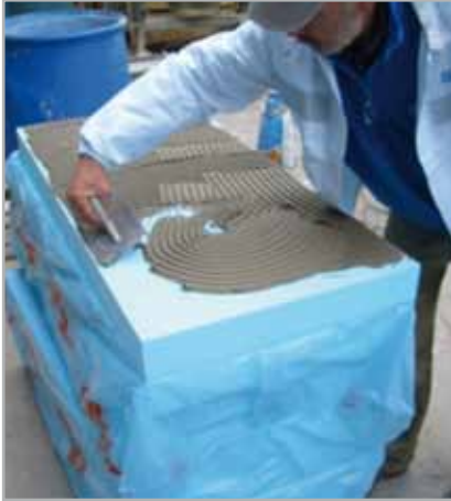
Fig. 7 - Stesura dell'adesivo sul retro pannello
