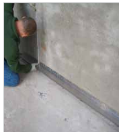
Fig. 6 - Posa del profilo di partenza MAPETHERM BA
